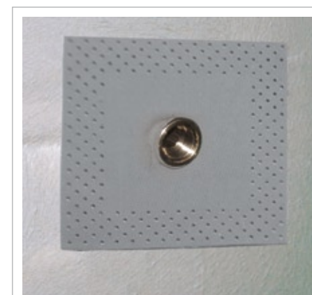
2b Заплатки Sopro EDMW 081 закрепляются на трубы.
