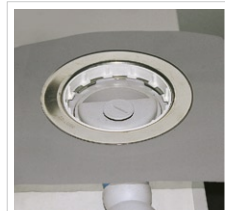
2c Для уплотнения водостоков применяется напольная заплатка EDMB 082.
