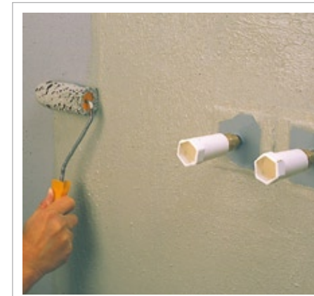
3b Затем на всю поверхность наносится гидроизоляция Sopro FDF 525 или Sopro DSF 523 с помощью валика или мастерка. После высыхания первого слоя наносим второй слой.
